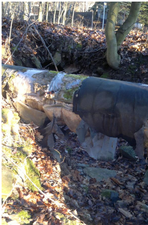
Obr. 1: Přejít stáv. zatrubnění DN700 přes potok. V pozadí výtokové čelo stáv. propustku
