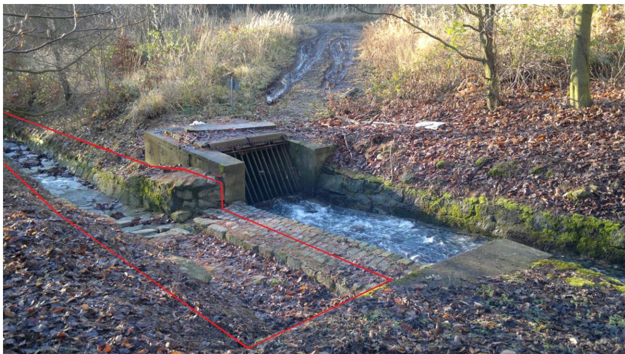
Obr. 2 : Stávající vtokový objekt do zatrubněné části s přelivnou hranou.
